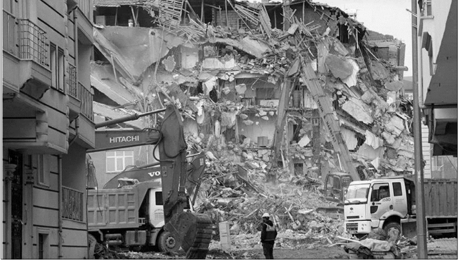
Şekil 86. Elazığ, depremde yıkılan yapılar (Demirdağ, 2020)
