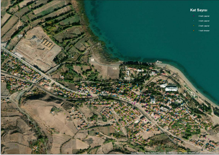
Şekil 60. Sivrice ilçesi, Gölbaşı mahallesi, kat sayılarına göre yapılar
