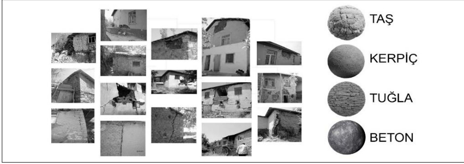
Şekil 39. Sivrice ilçesi, kullanılan yapı malzemeleri
