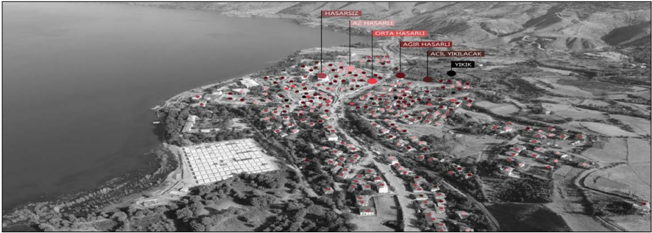
Şekil 40. Sivrice ilçesi merkezi hasar durumu 17
