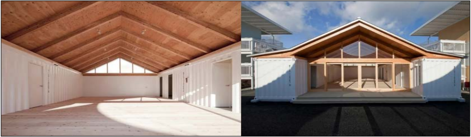
Şekil 97. Onagava Geçici Konutları, iç mekân ve cephe (Shigeru Ban Architects, 2011)
