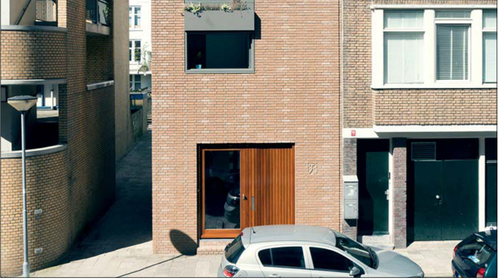
Şekil 88. Konut, Architectuur Maken, ev molozdan oluşmuş olan atık tuğlalardan yapılmıştır (Gürkan, 2017)
